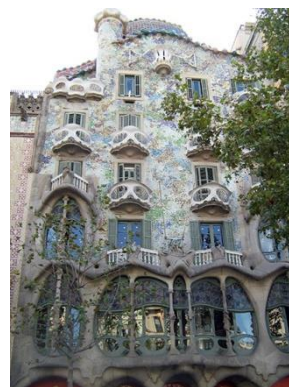
Дом Бальо, Барселона
