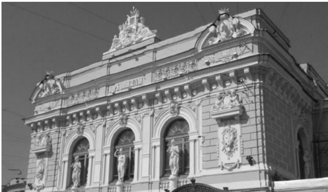
Фасад цирка Чинизелли (в центре скульптура – муза Полигимния, слева и справа от неё – муза Эвтерпа)
